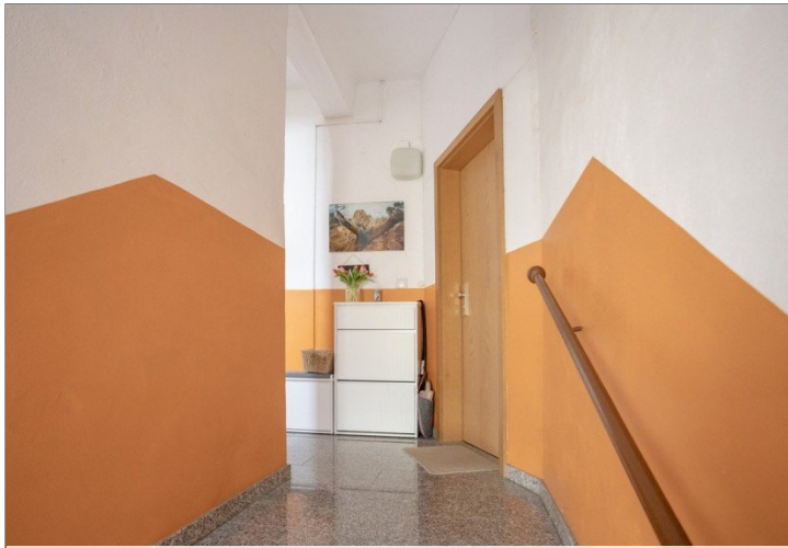
Treppenhaus Zugang Wohneinheit EG
